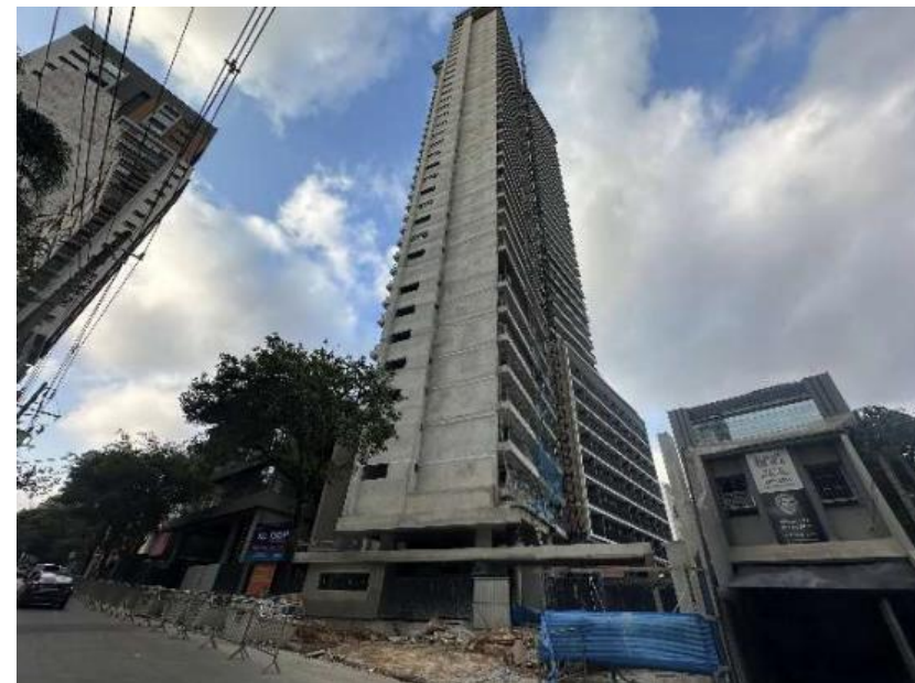
Foto da obra.
