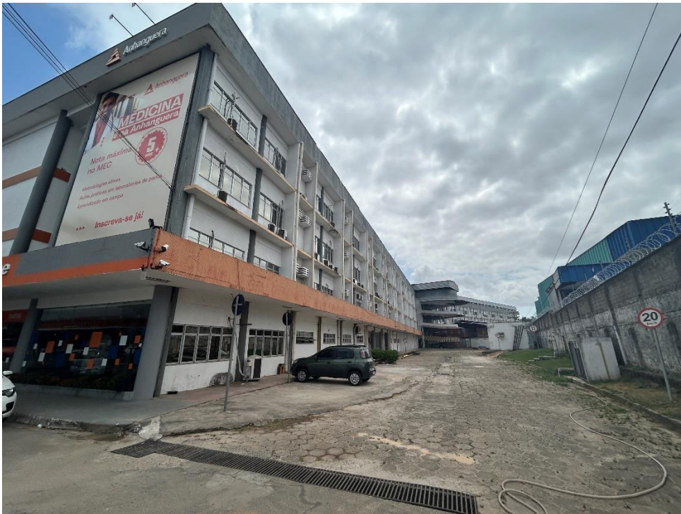
Vista Geral do Imóvel
