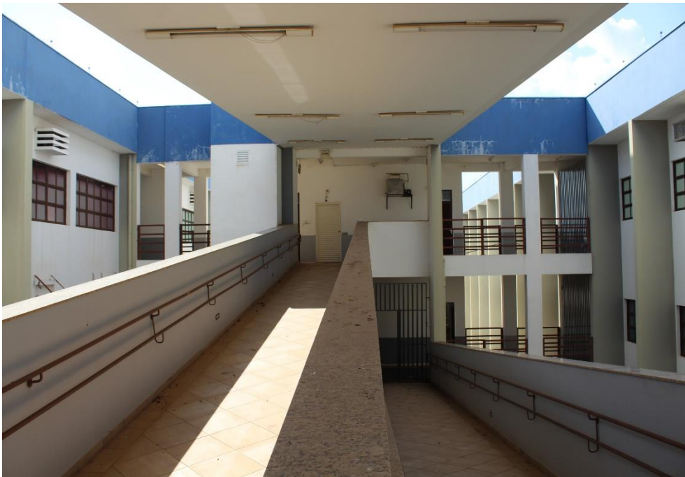
Vista interna do imóvel
