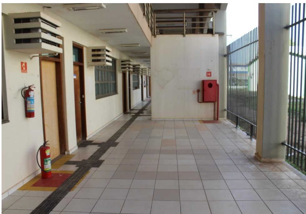
Vista interna do imóvel
