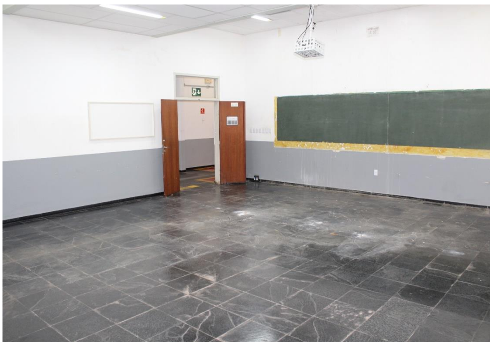
Vista interna do imóvel
