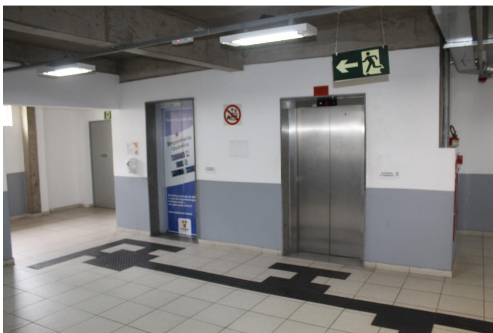
Hall de elevadores
