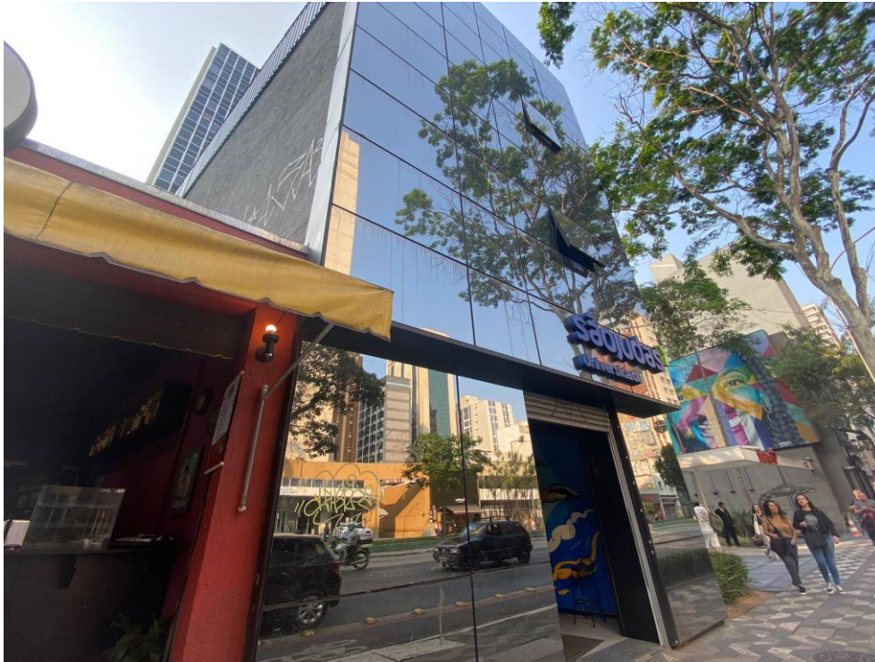
Fachada do Imóvel (Rua da Consolação, 2320)
