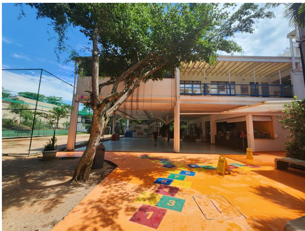
Vista geral do imóvel
