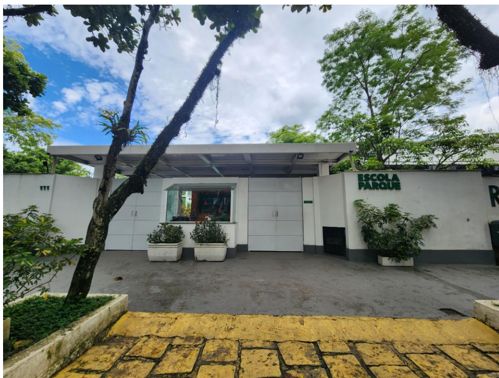
Vista Geral da Fachada do Imóvel
