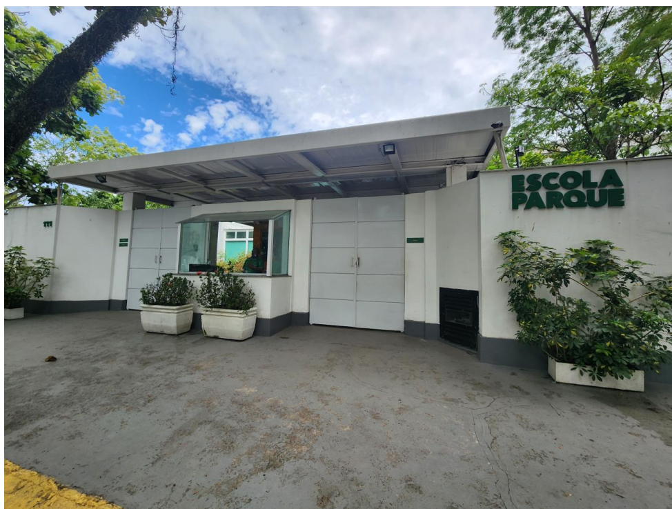
Vista Geral da Fachada do Imóvel
