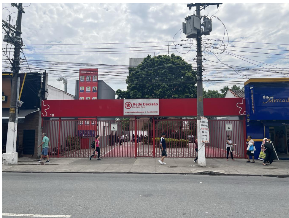
Vista Geral da Fachada do Imóvel
