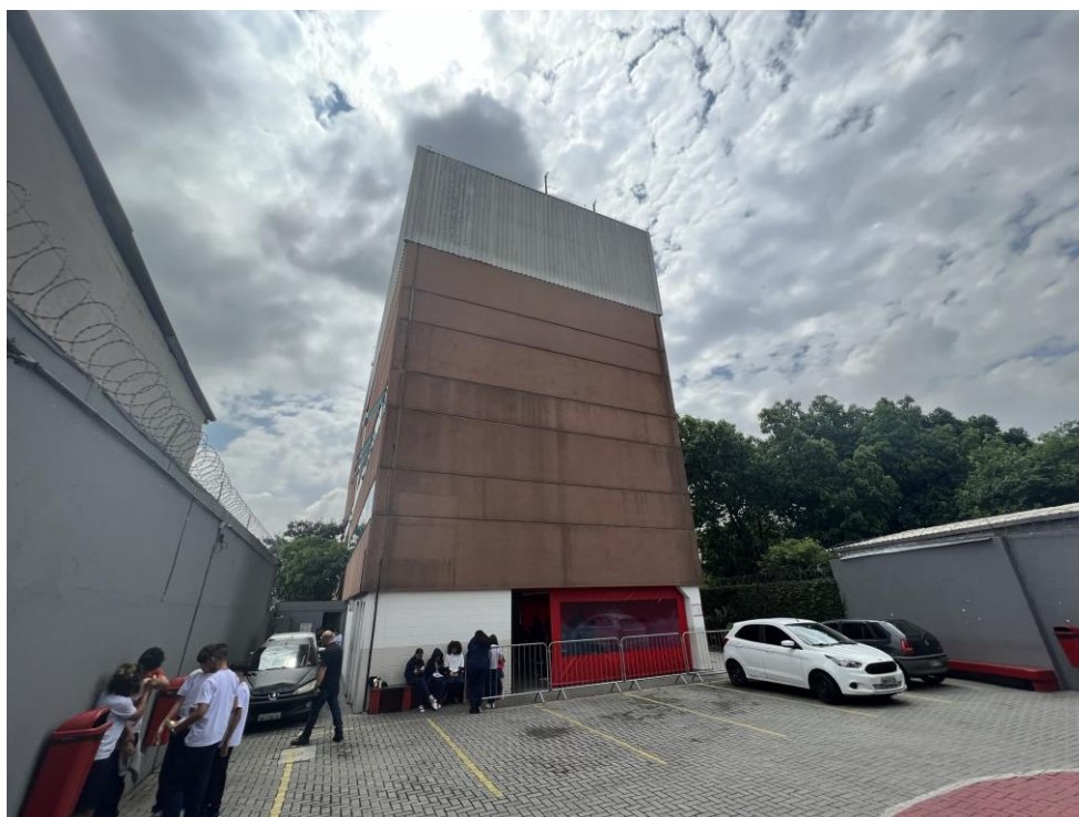
Vista Geral da Fachada do Imóvel
