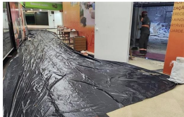
Tapume de isolamento da obra e proteção para retirada de entulho.
