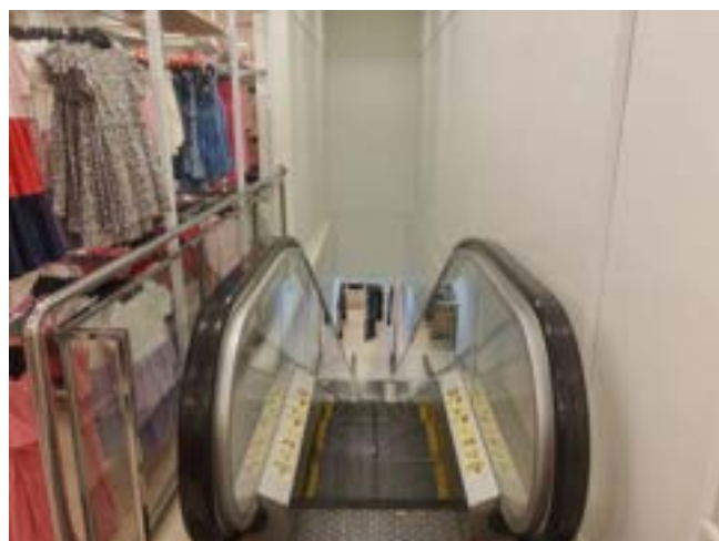
ESCADA DE ACESSO
