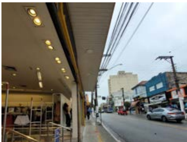
VIA DE ACESSO AO IMÓVEL
