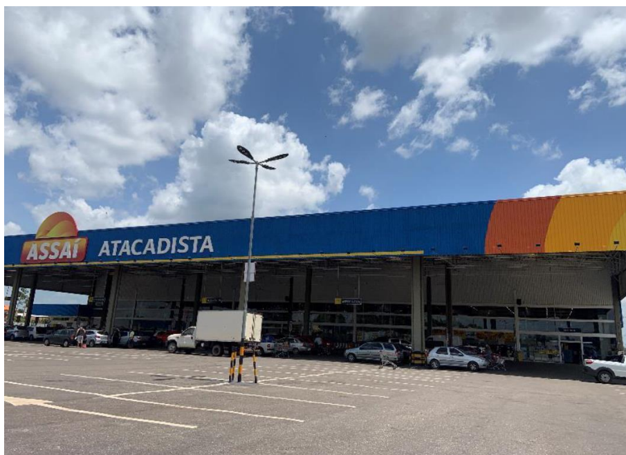
Vista Geral da Fachada do Imóvel
