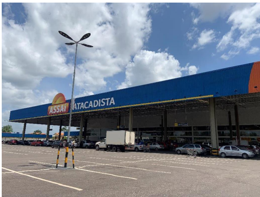
Vista Geral da Fachada do Imóvel
