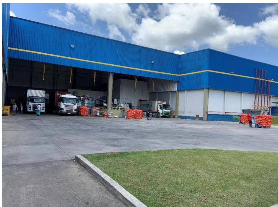
Vista Geral da Área de Docas
