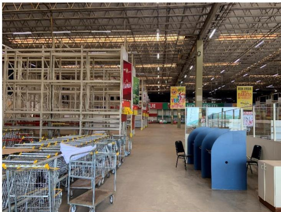
Vista Geral interna
