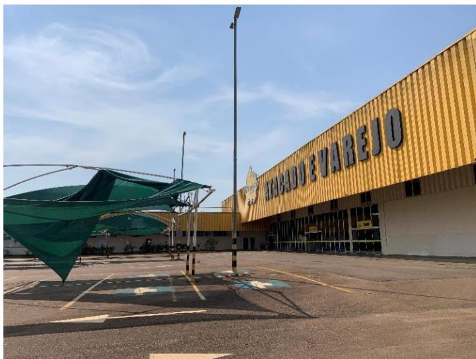
Vista Geral da Fachada do Imóvel
