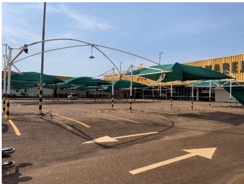
Vista Geral da Fachada do Imóvel
