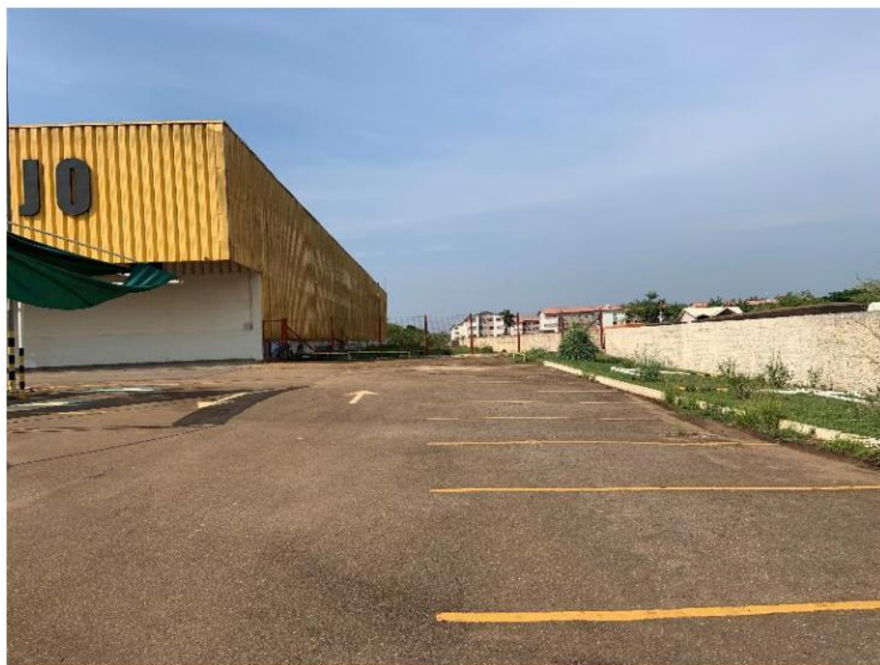
Vista Geral da Área de Estacionamento
