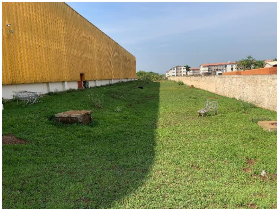
Vista Geral externa
