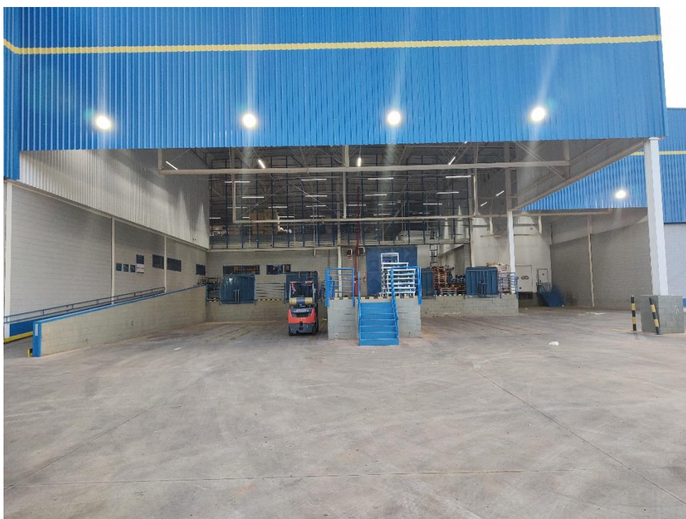
Vista Geral da Área de Docas
