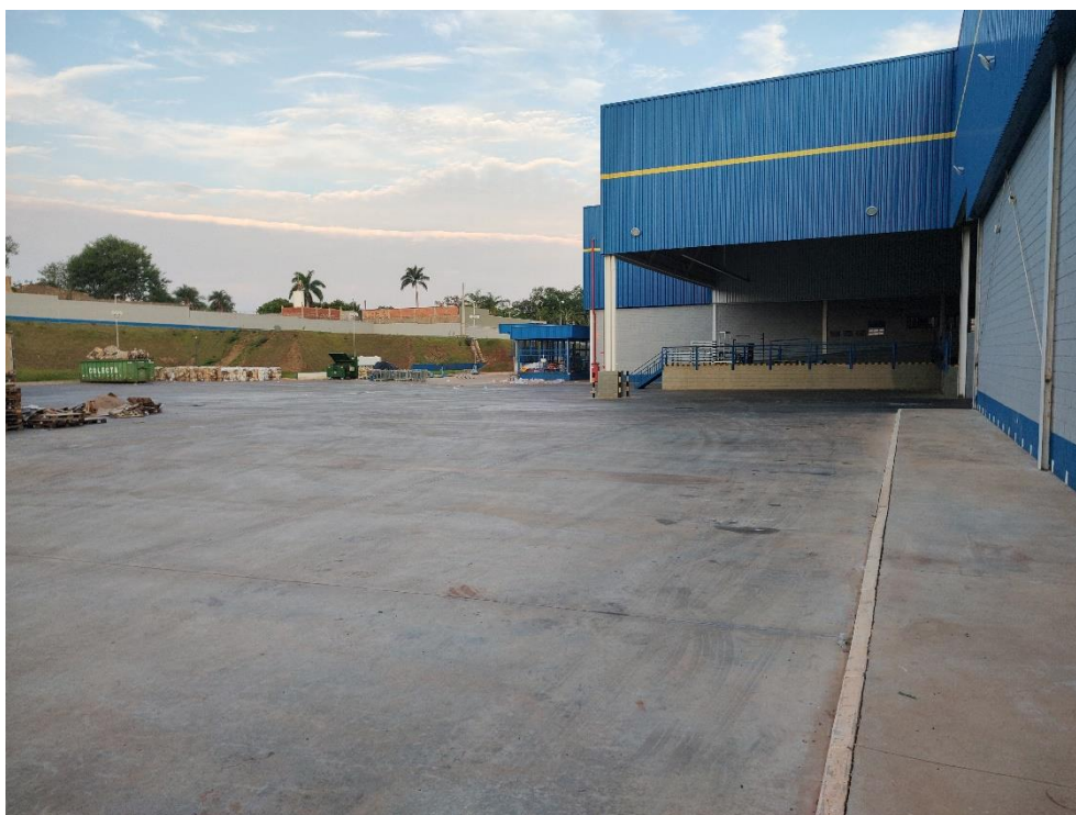
Vista Geral da Área de Docas
