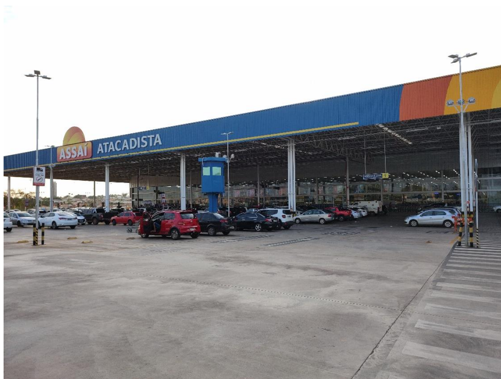
Vista Geral da Fachada do Imóvel
