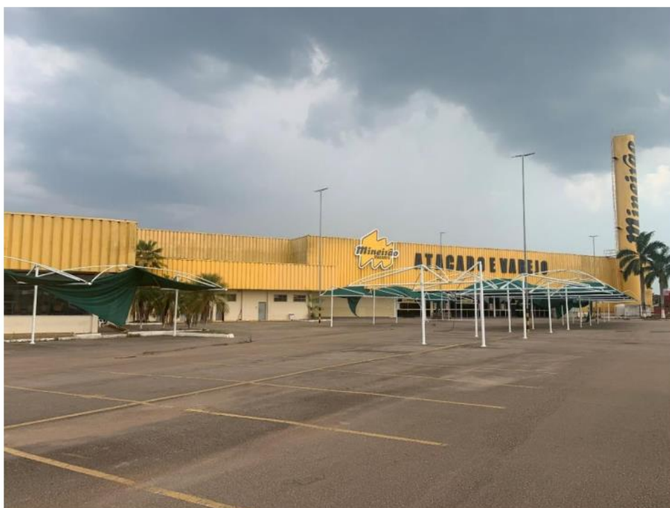
Vista Geral da Fachada do Imóvel
