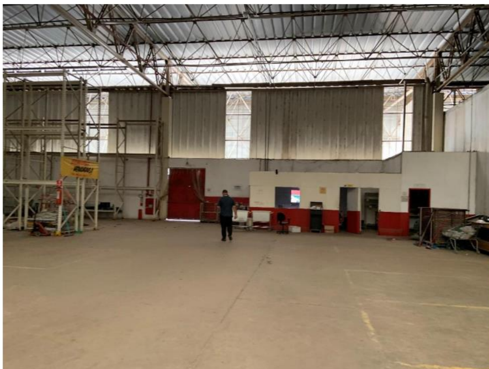
Vista Geral interna
