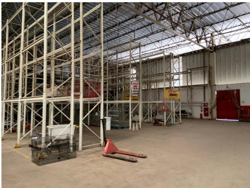
Vista Geral interna
