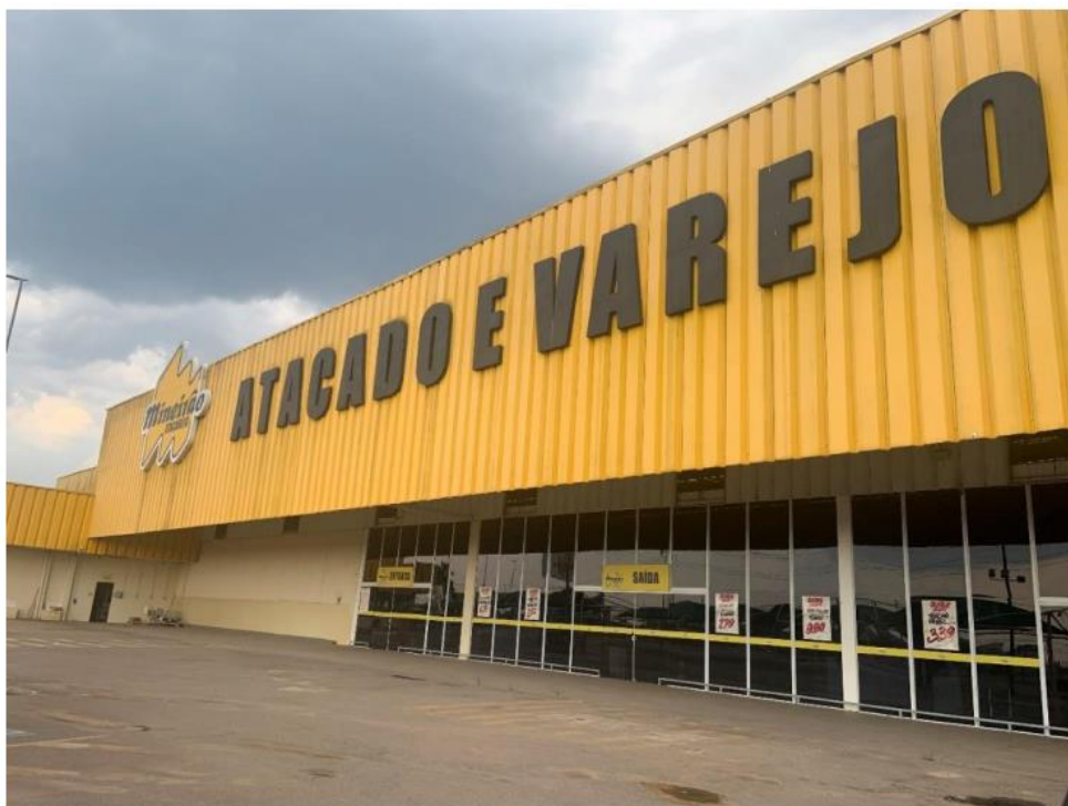
Vista Geral da Fachada do Imóvel
