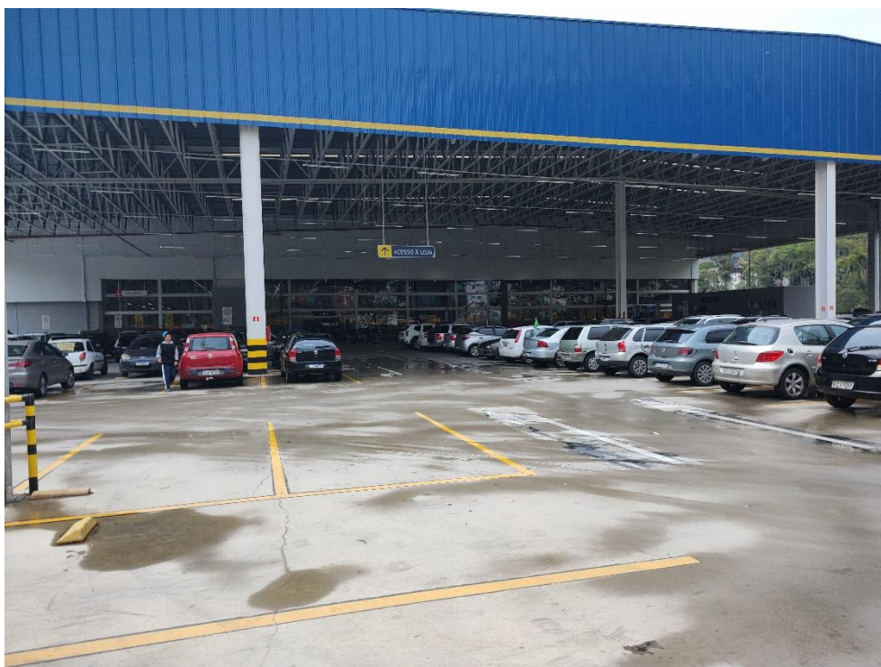
Vista Geral da Fachada do Imóvel
