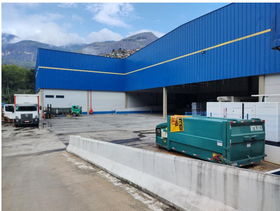
Vista Geral da Área de Docas
