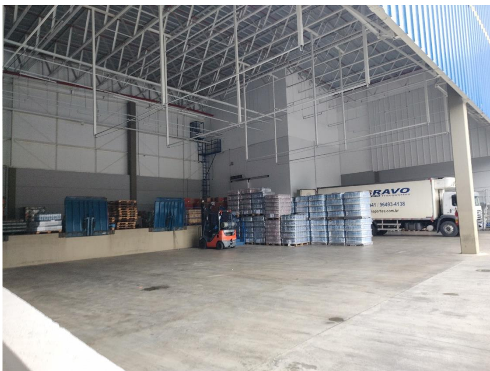
Vista Geral da Área de Docas
