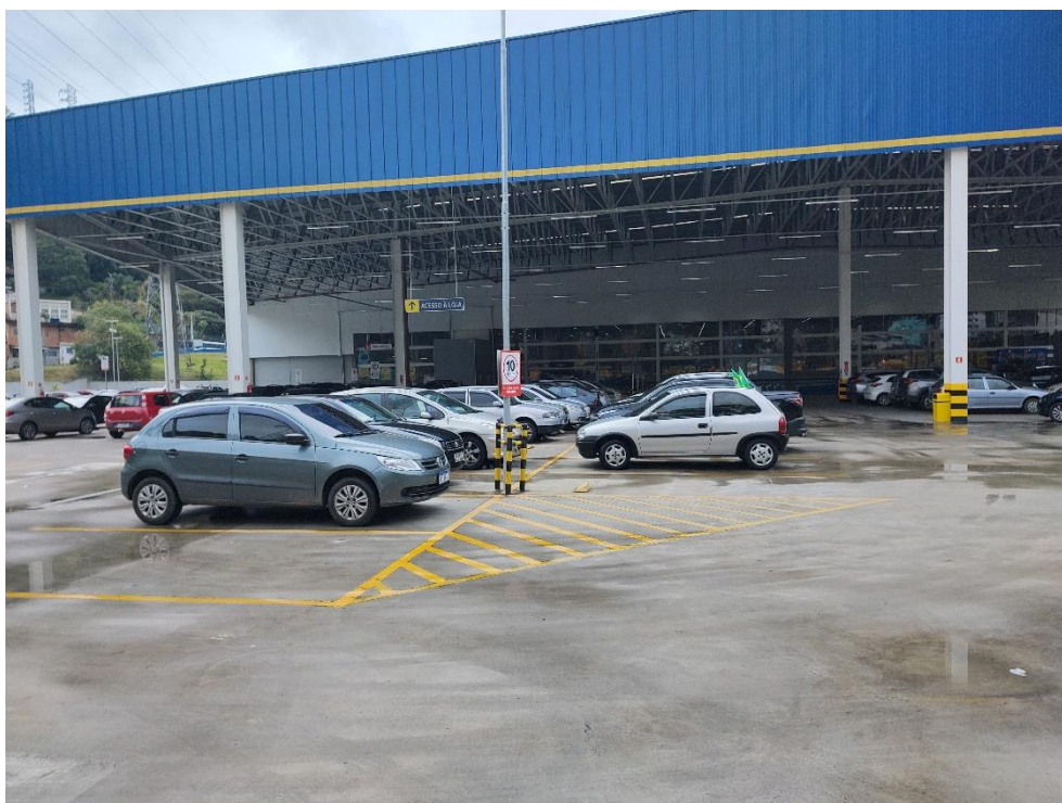
Vista Geral da Fachada do Imóvel
