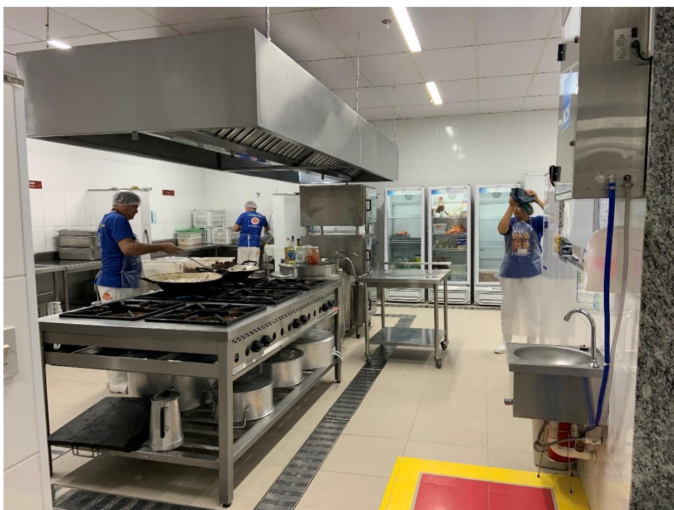
Vista Geral da Cozinha
