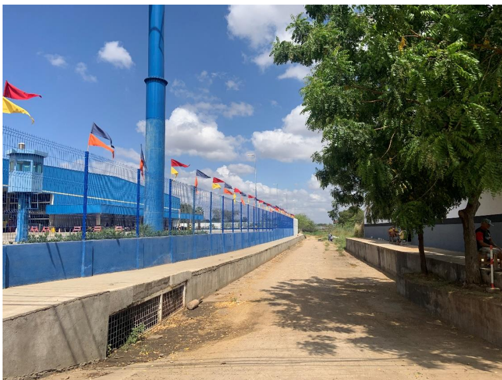
Vista Geral da Fachada do Imóvel
