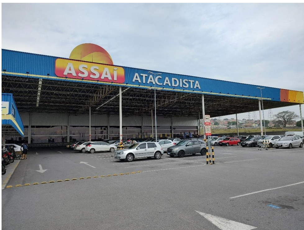
Vista Geral da Fachada do Imóvel
