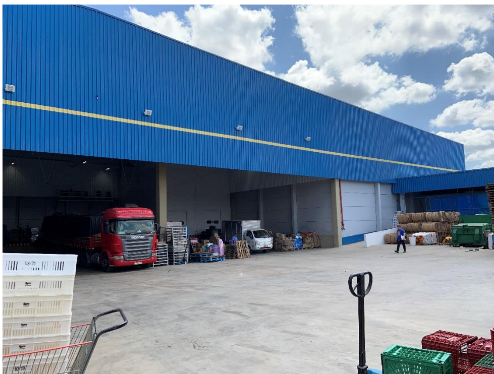
Vista Geral da Área de Docas
