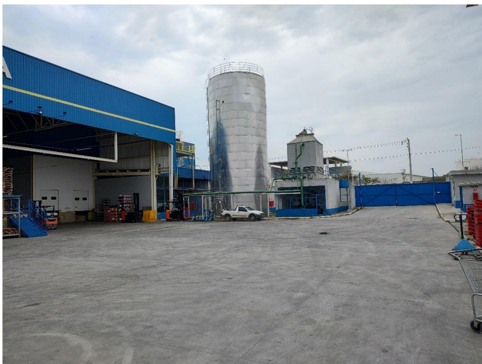
Vista Geral da Área de Docas
