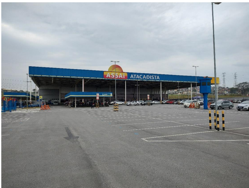
Vista Geral da Fachada do Imóvel
