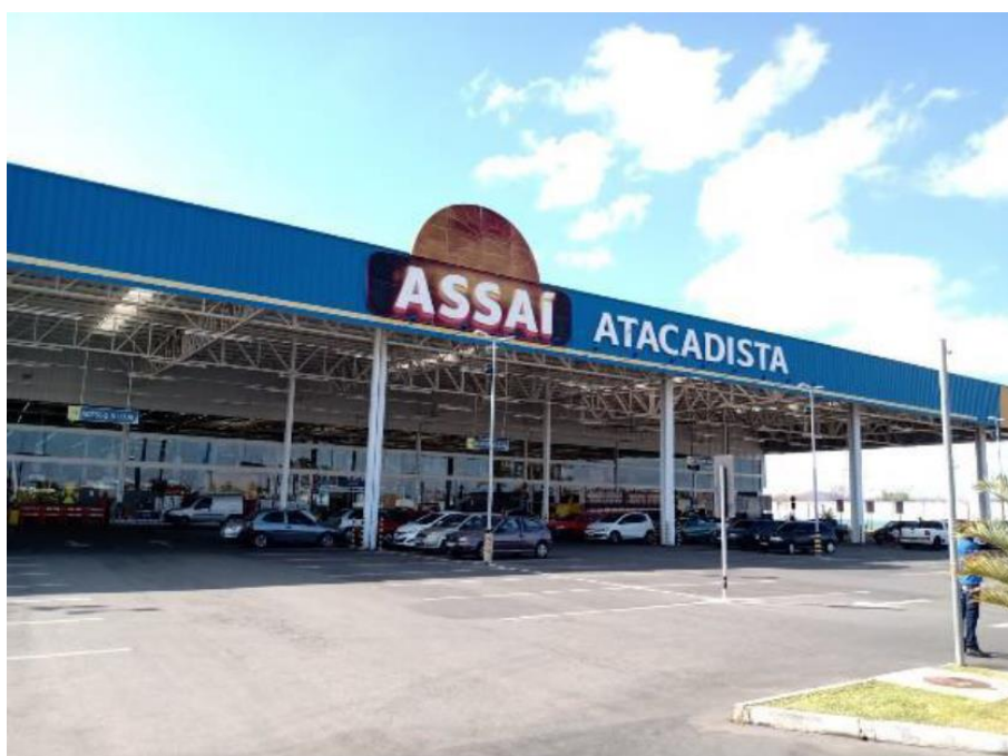
Vista Geral da Fachada do Imóvel
