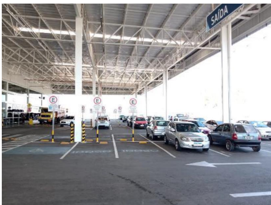
Vista Geral da Área de Estacionamento
