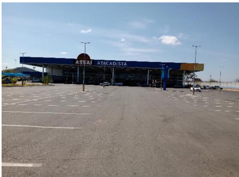
Vista Geral da Fachada do Imóvel
