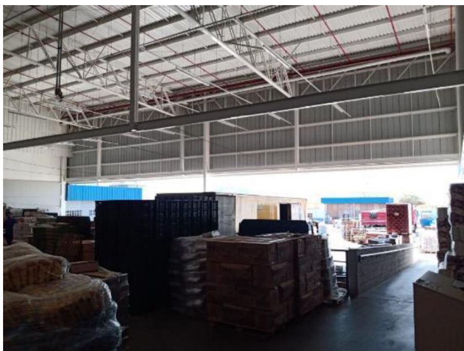
Vista Geral da Área de Estacionamento Coberto
