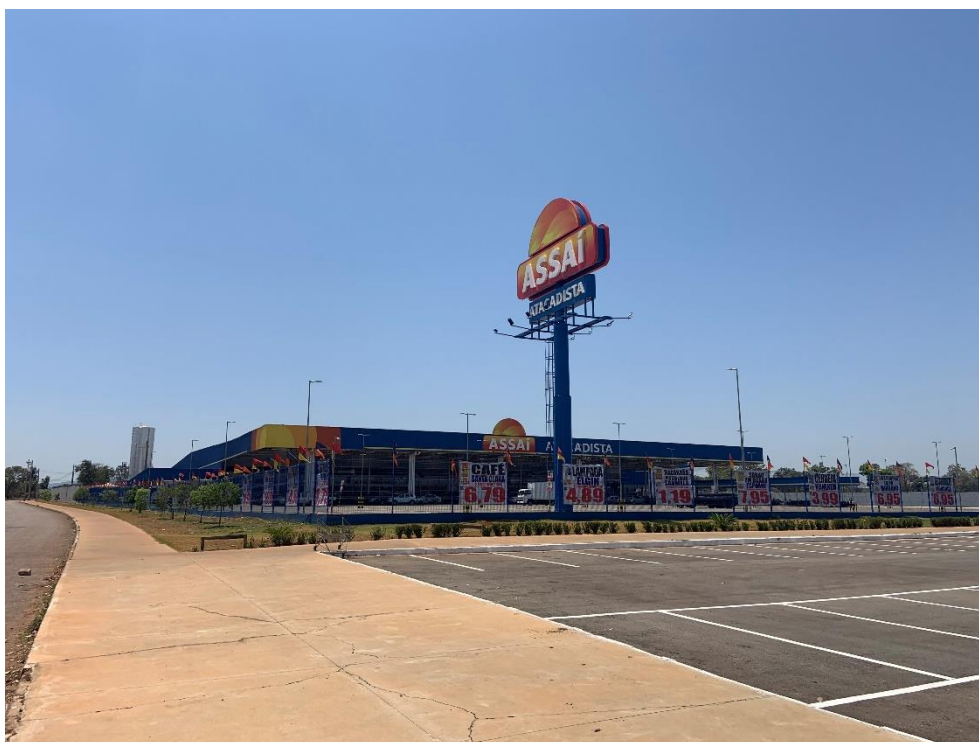
Vista Geral da Fachada do Imóvel
