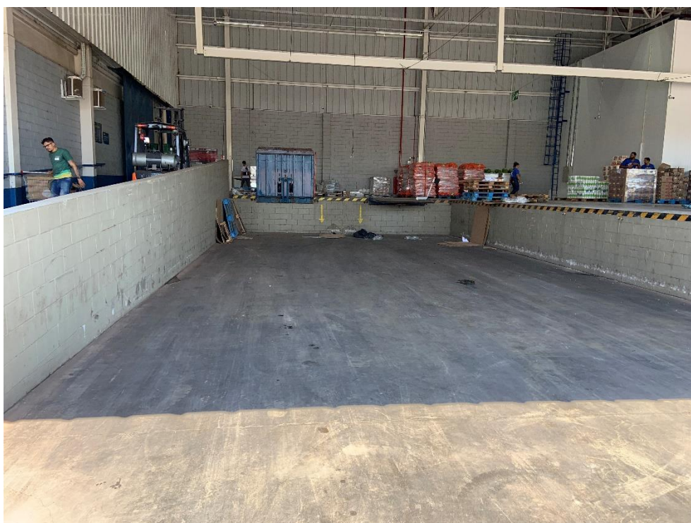
Vista Geral da Área de Docas
