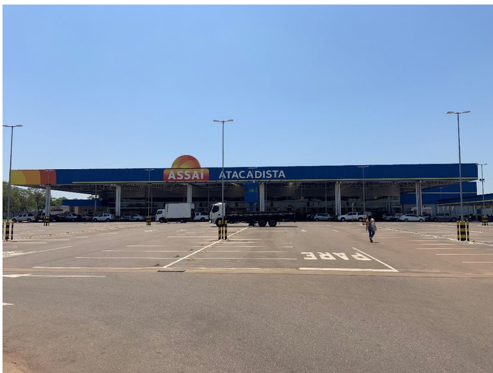
Vista Geral da Fachada do Imóvel
