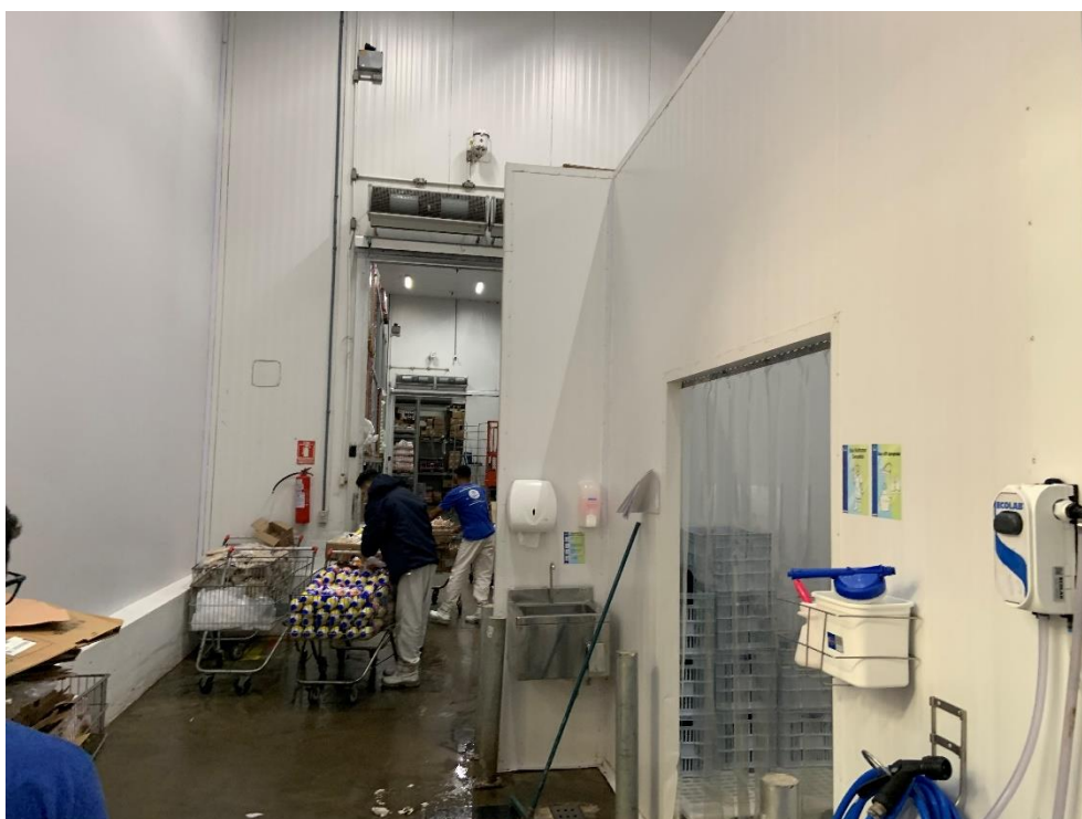
Vista da Área de Câmaras Frias
