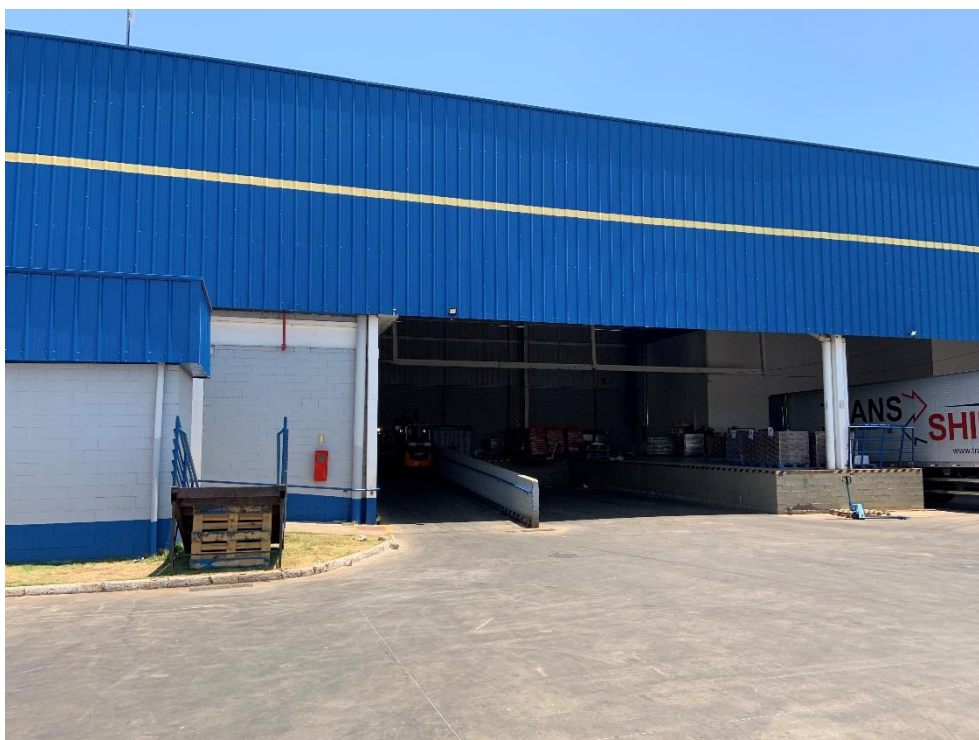
Vista Geral da Área de Docas
