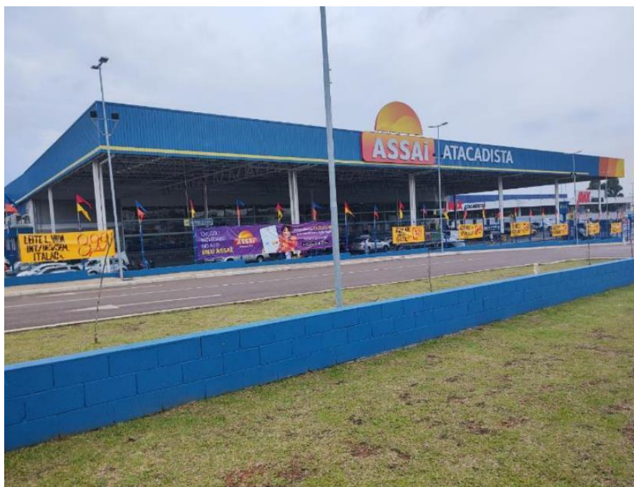
Vista geral da fachada do imóvel
