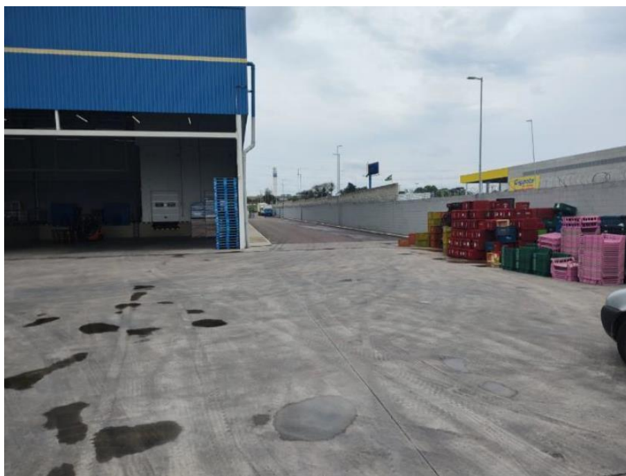
Vista Geral da Área de Carga e Descarga
