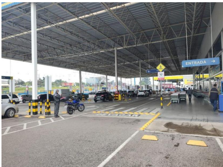
Vista Geral da Área de Estacionamento Coberto
