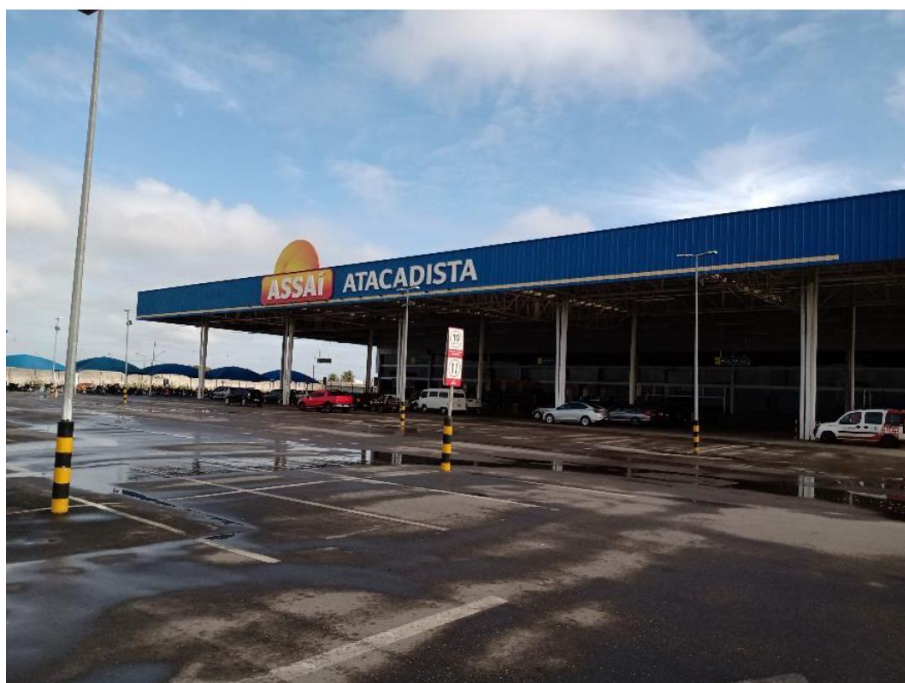
Vista Geral da Fachada do Imóvel
