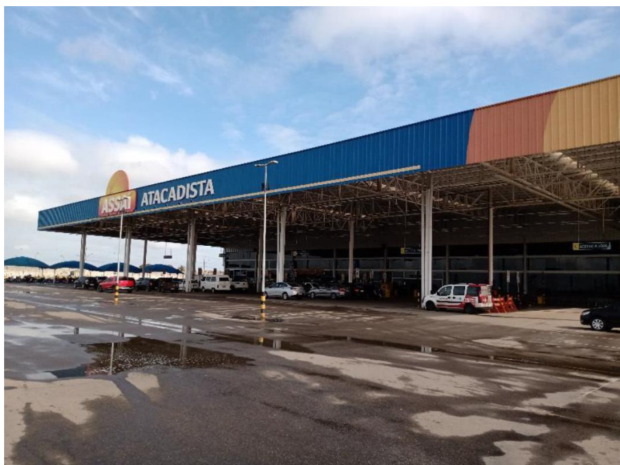
Vista Geral da Fachada do Imóvel
