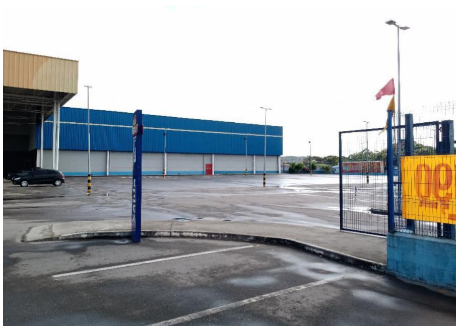
Vista Geral da Área de Estacionamento
