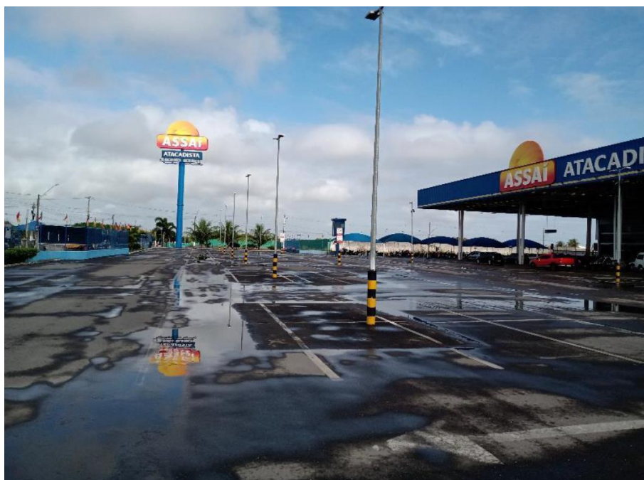
Vista Geral da Área de Estacionamento
