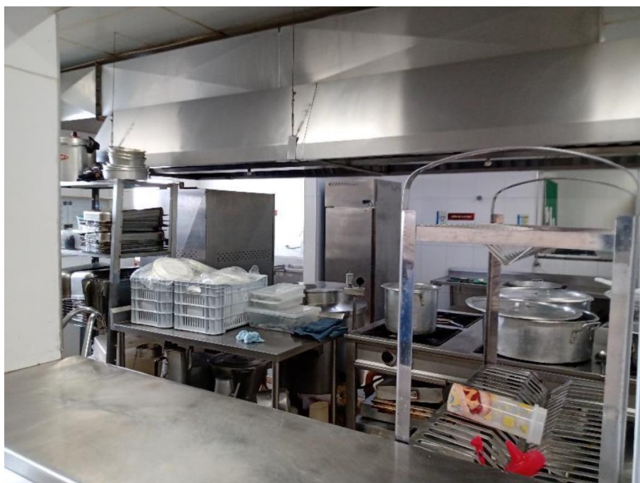
Vista Geral da Cozinha
