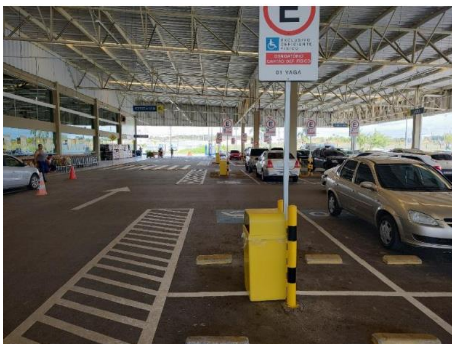
Vista Geral da Área de Estacionamento
