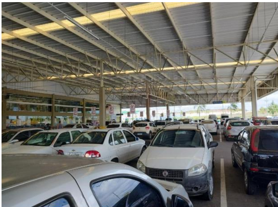
Vista Geral da Área de Estacionamento
