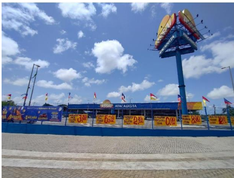
Vista Geral da Fachada do Imóvel
