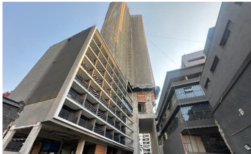
Foto da obra.
