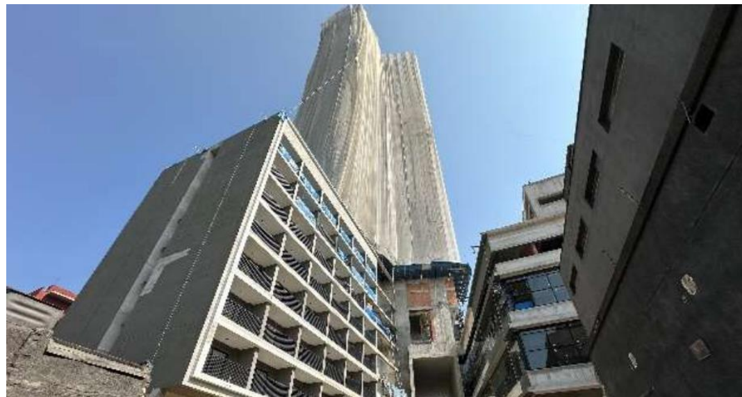
Foto da obra.
