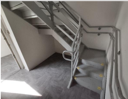
Escada de acesso ao 15º andar
