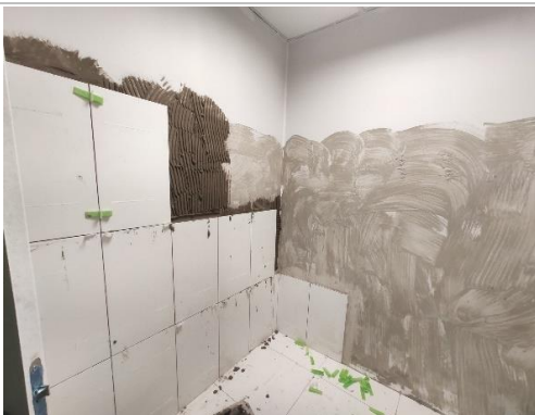
Clínica veterinária (áreas em reforma) – 1º subsolo
