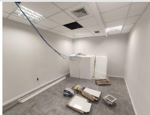
Clínica veterinária (áreas em reforma) – 1º subsolo
