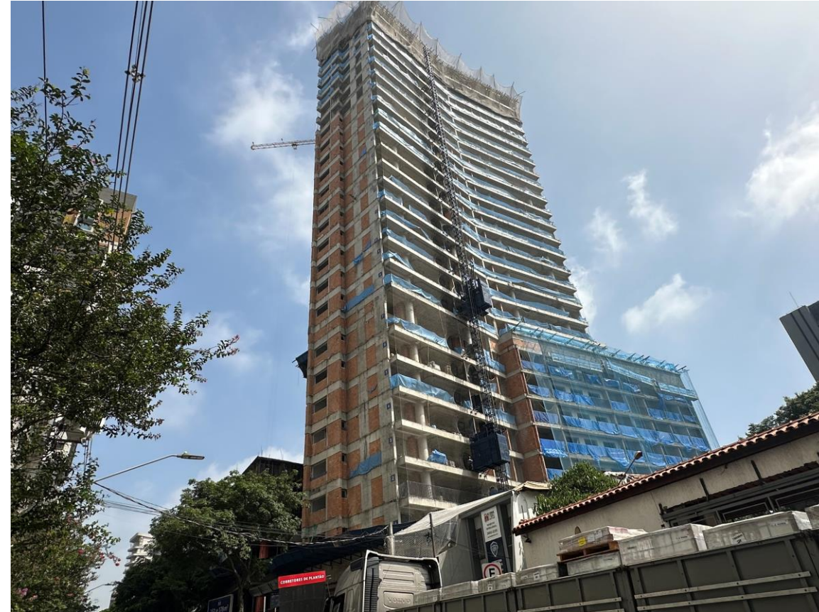
Foto da obra.
