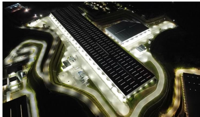
Execução de obras – Foto Panorâmica
