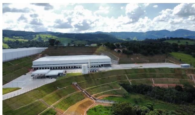
Execução de obras – Foto Panorâmica
