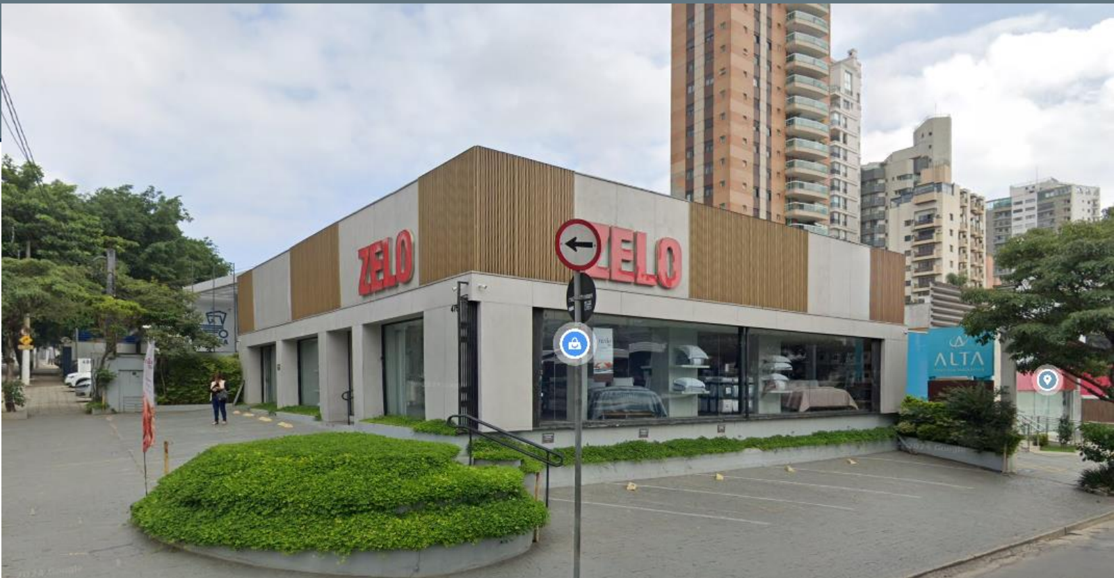
Situação Atual (pré-reforma)
