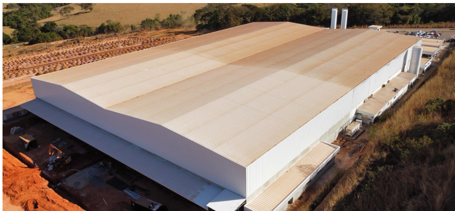
Vista Aérea do Galpão
