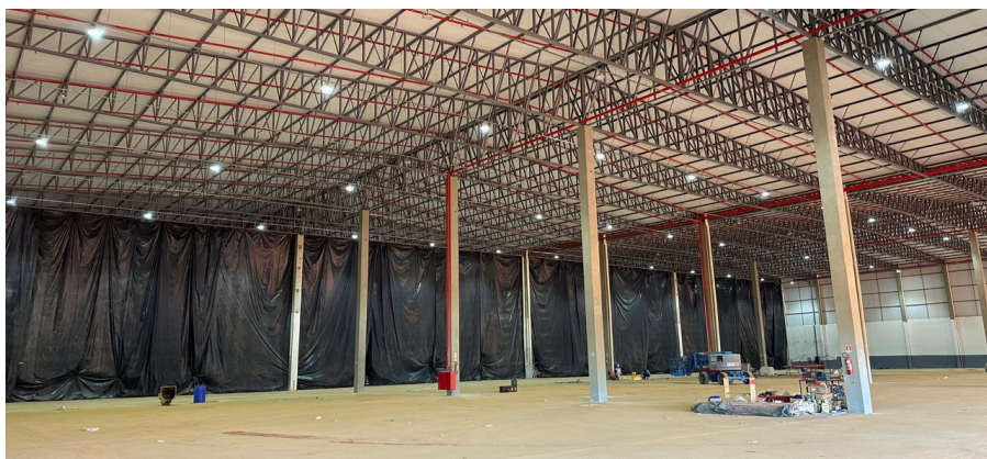
Área Interna do Galpão - Ampliação Fase 01
