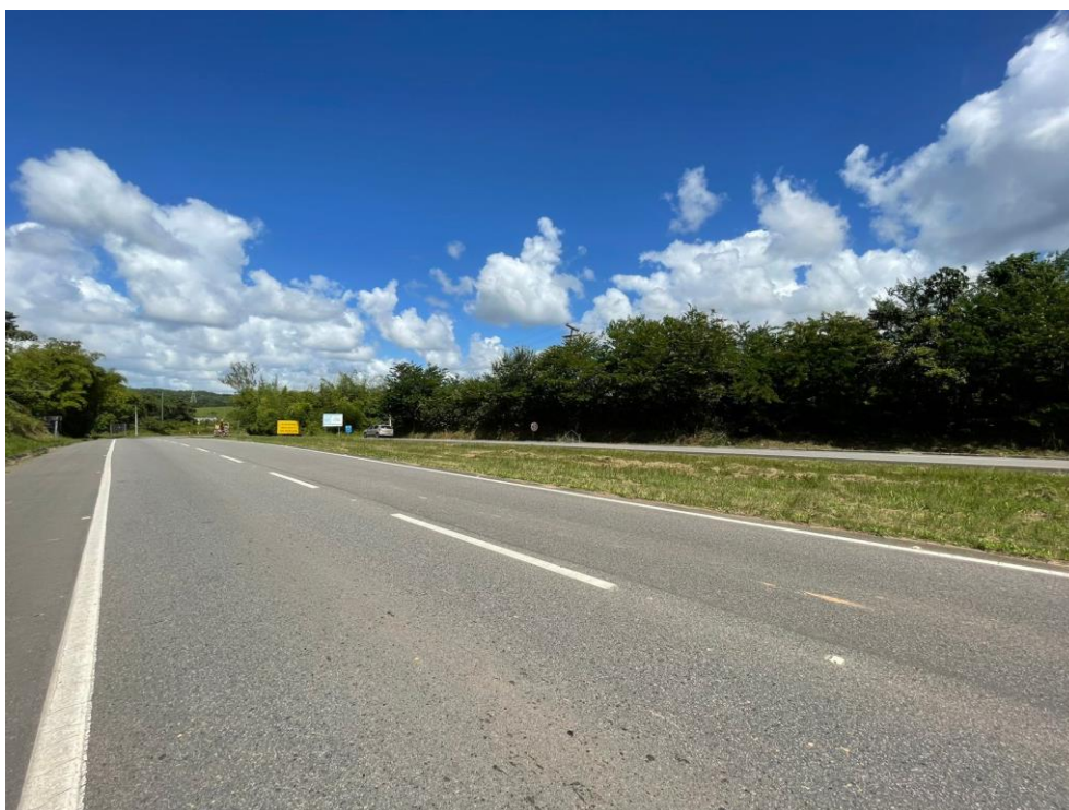
Via de acesso ao imóvel
