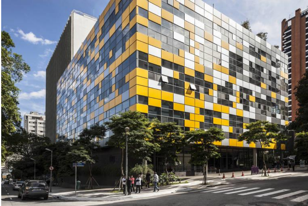
Imagem do Edifício Módulo Rebouças
