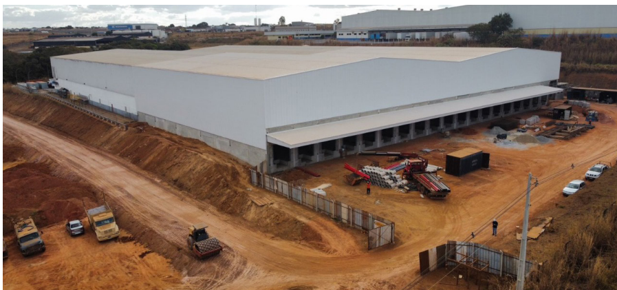
Vista Aérea do Galpão
