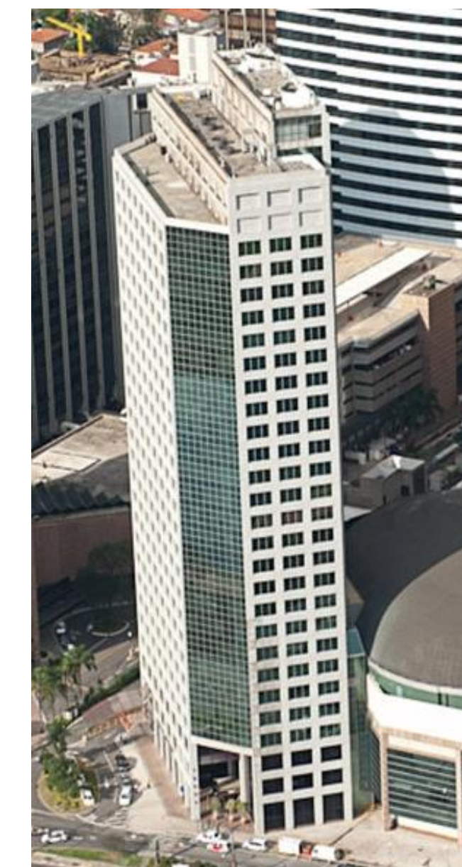
Torre de Escritórios
