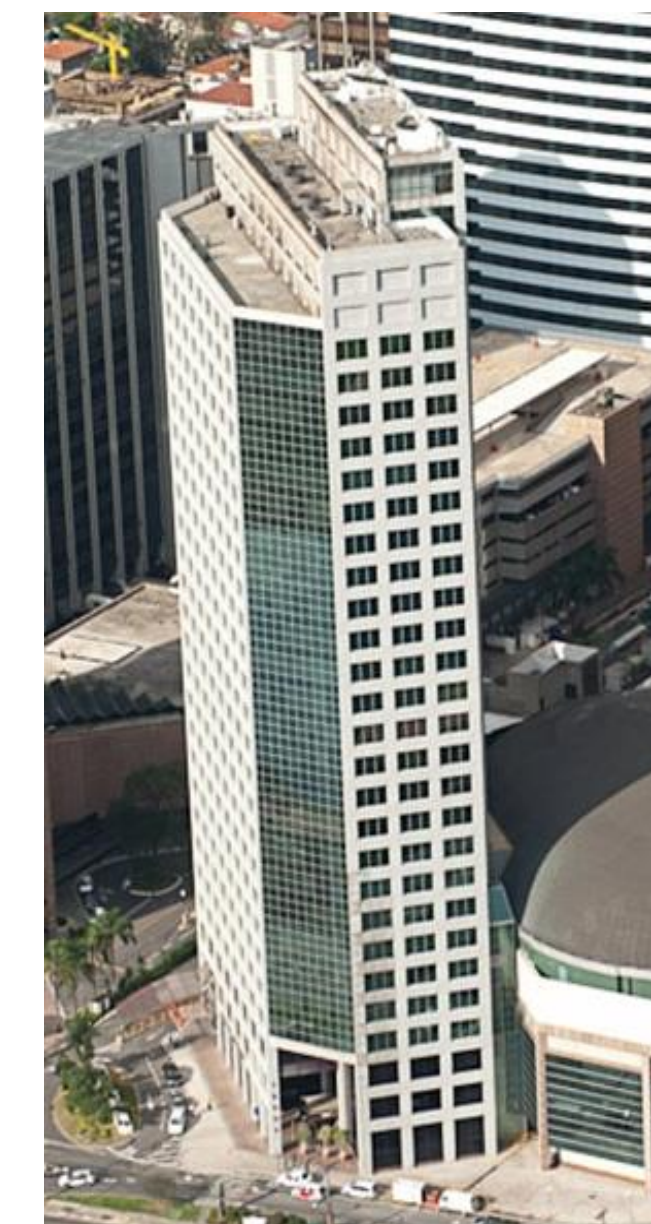
Torre de Escritórios
