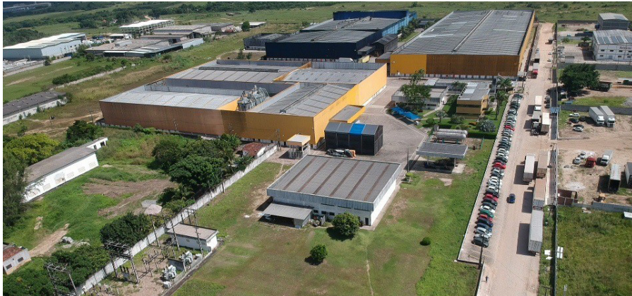
Vista Aérea do Galpão
