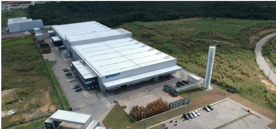
Vista Aérea do Galpão
