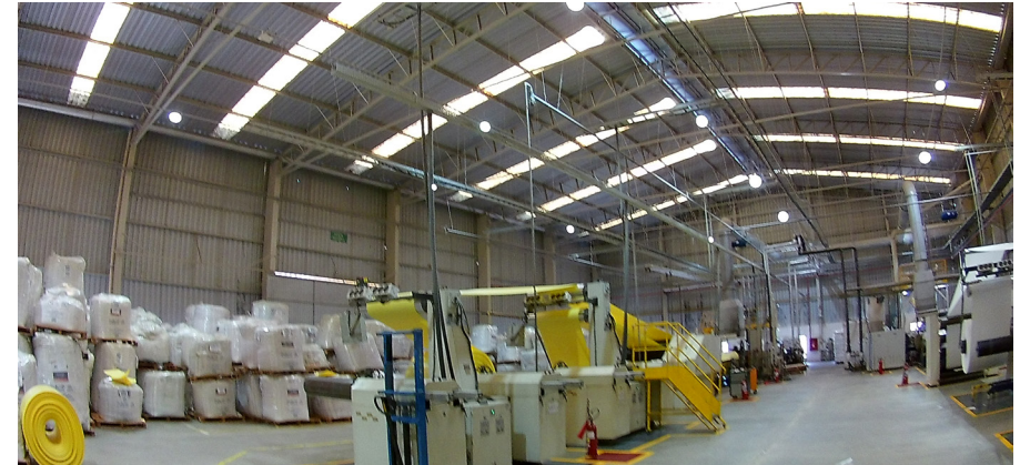
Área Interna do Galpão
