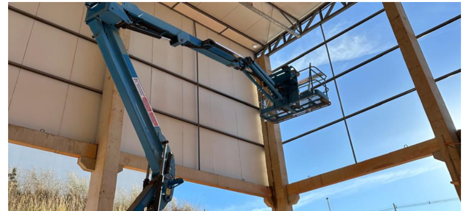
Obras de Ampliação - Fase 1
