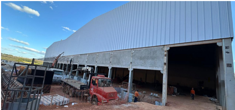
Obras de Ampliação - Fase 1
