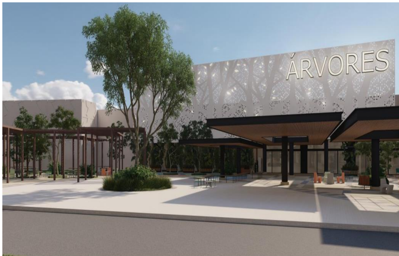
Início as obras de revitalização no corredor das árvores em 25/07
