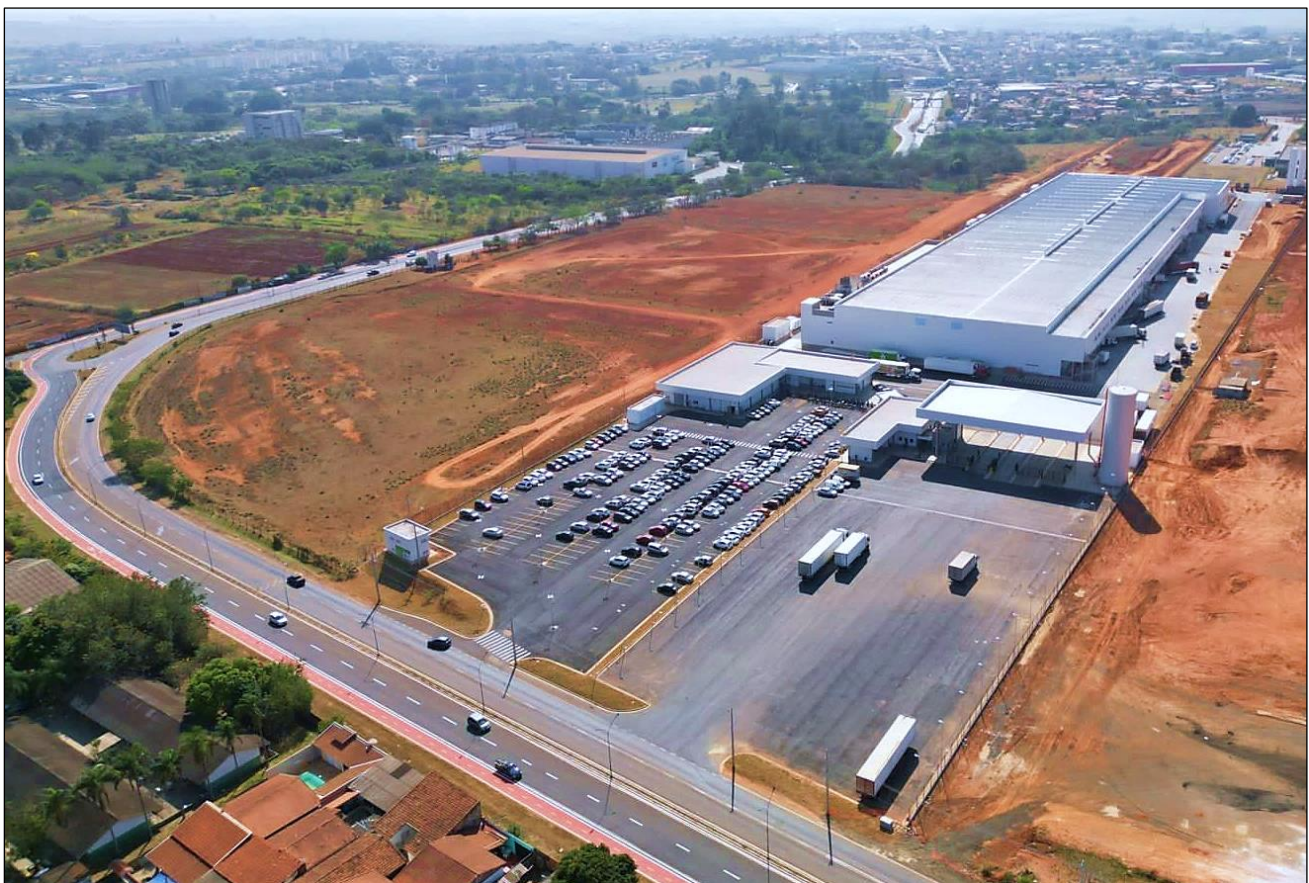
Centro de Distribuição Oba Sumaré/SP: vista recente do empreendimento, com mais de 33,7 mil m 2 de área construída, além de expansão aprovada de mais 14,1 mil m 2 .
