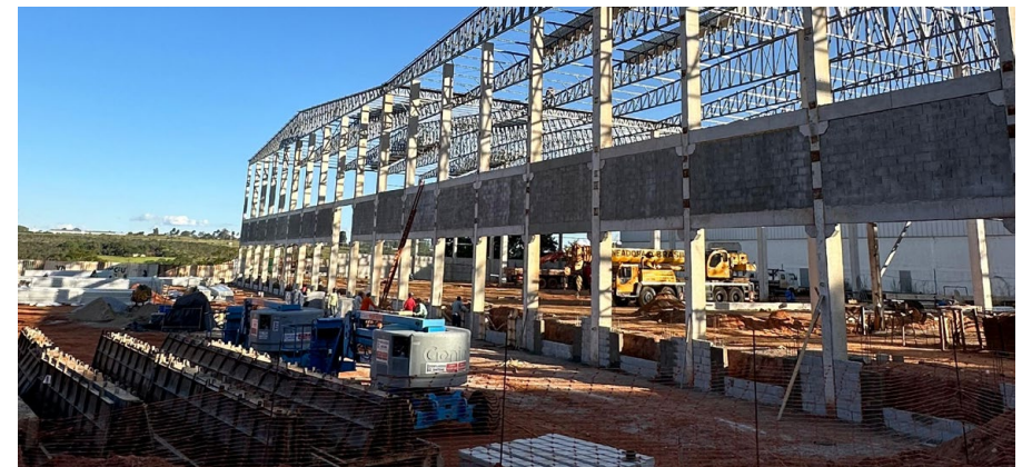
Obras de Ampliação - Fase 1
