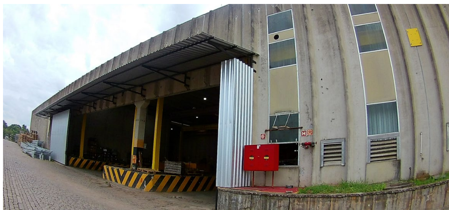
Área Externa do Galpão
