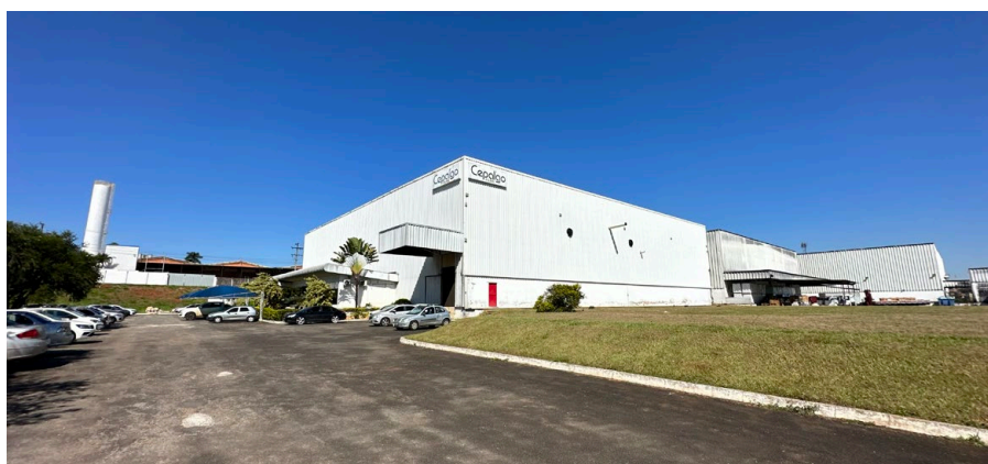
Área Externa do Galpão
