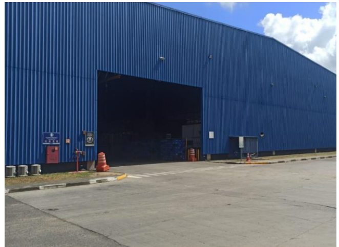
VISTA EXTERNA GALPÃO
