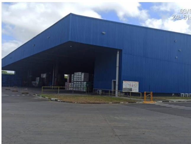
VISTA EXTERNA GALPÃO
