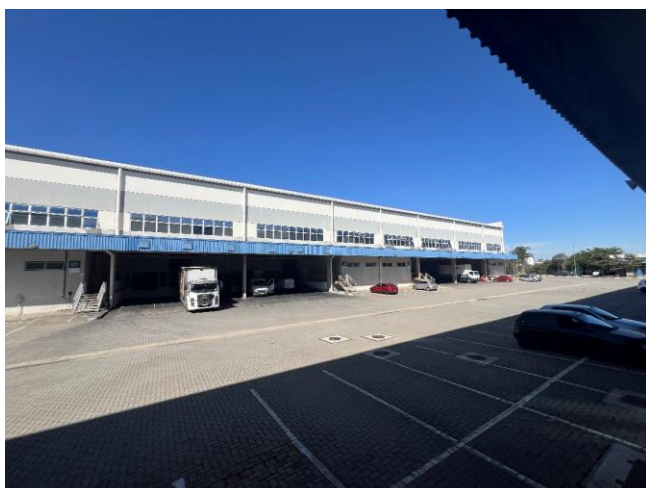
VISTA GERAL GALPÃO
