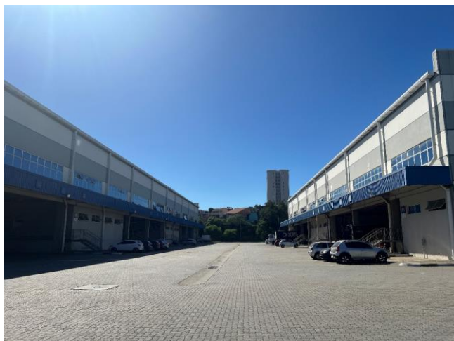
VISTA GERAL GALPÕES
