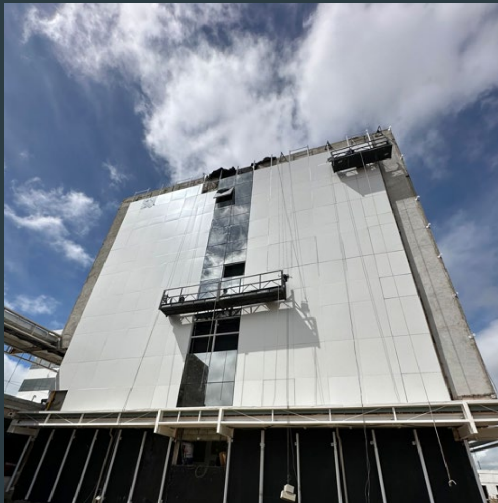
Fachada Externa/Lateral Pele de Vidro
