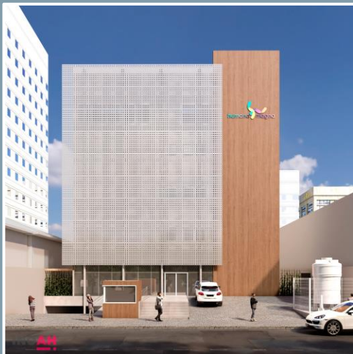
Rede Humana Magna | Imagem de referência da unidade Pompéia (em obras)
