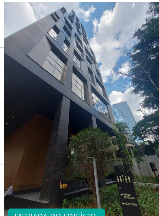
ENTRADA DO EDIFÍCIO
