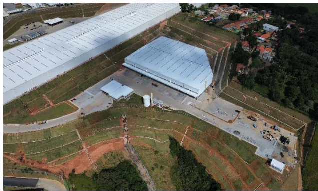
Execução de obras – Foto Panorâmica
