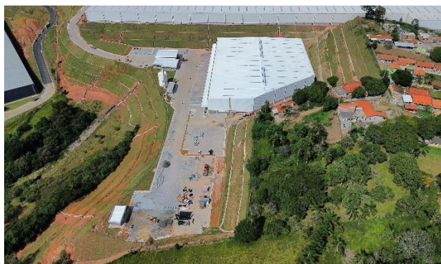
Execução de obras – Foto Panorâmica
