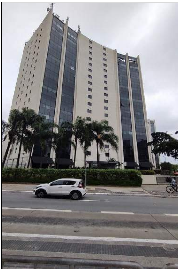
FACHADA DO EDIFÍCIO
