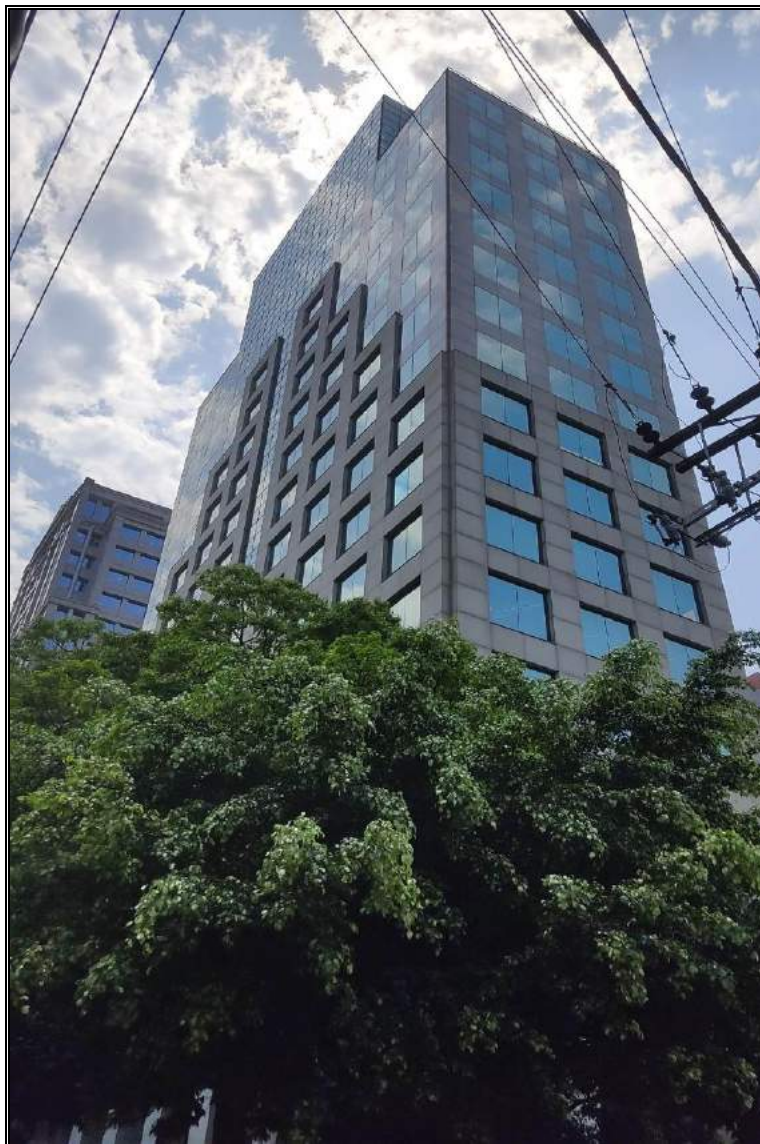
FACHADA DO EDIFÍCIO
