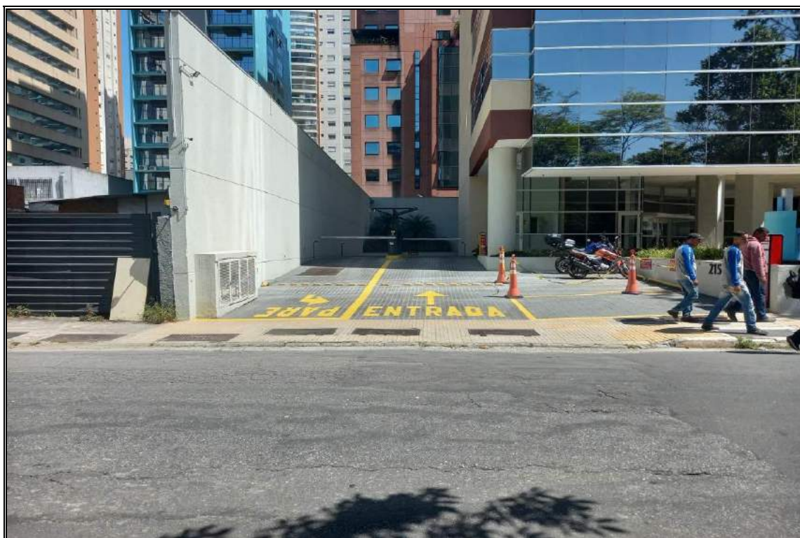
ACESSO AO SUBSOLO
