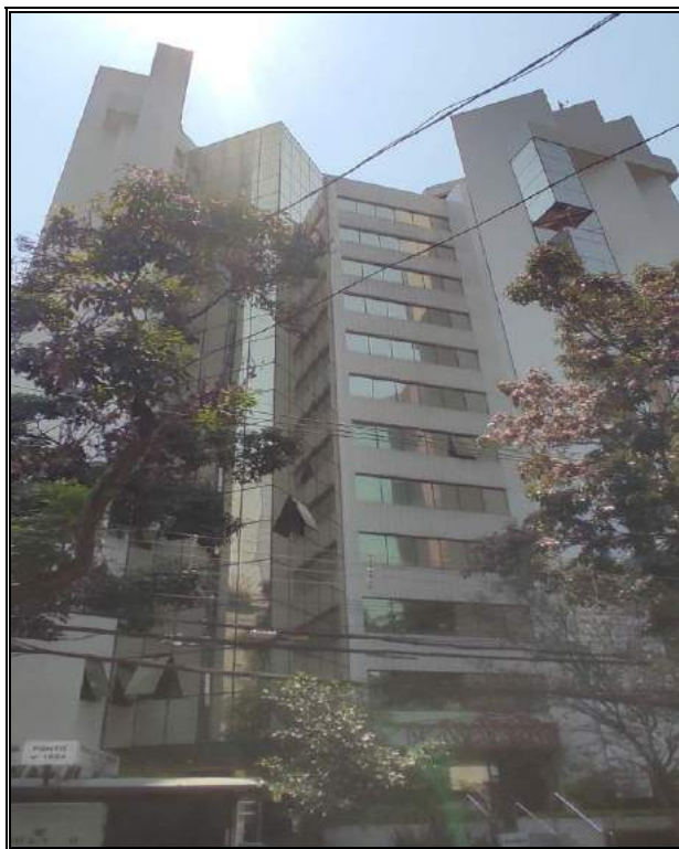
FACHADA DO EDIFÍCIO
