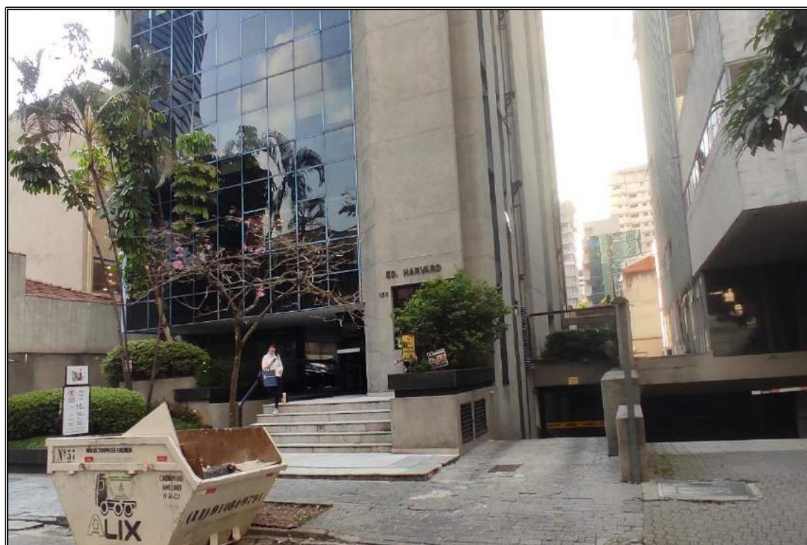
RAMPA DE ACESSO AO SUBSOLO
