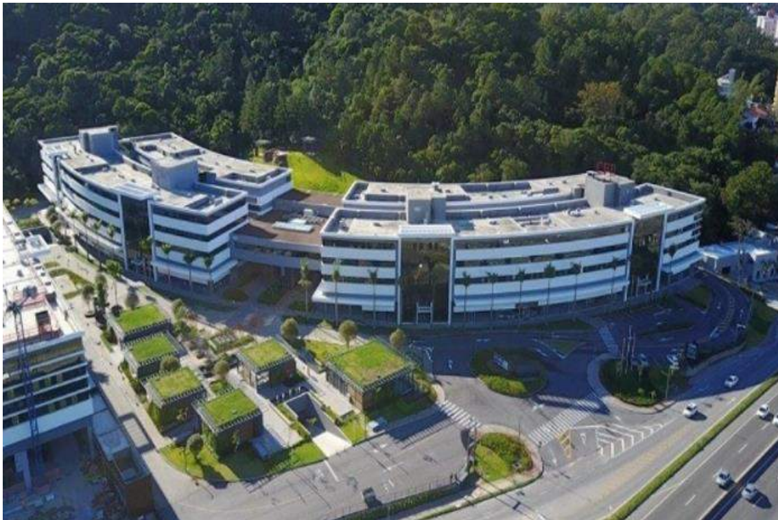
VISTA GERAL DO EMPREENDIMENTO (Fonte Site Giacomelli - Imóveis - Ofertas)
