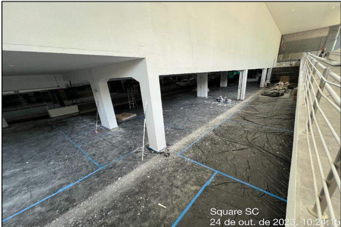
ACESSO AO SUBSOLO – ÁREA LOCADA PARA LOJA DE MÓVEIS
