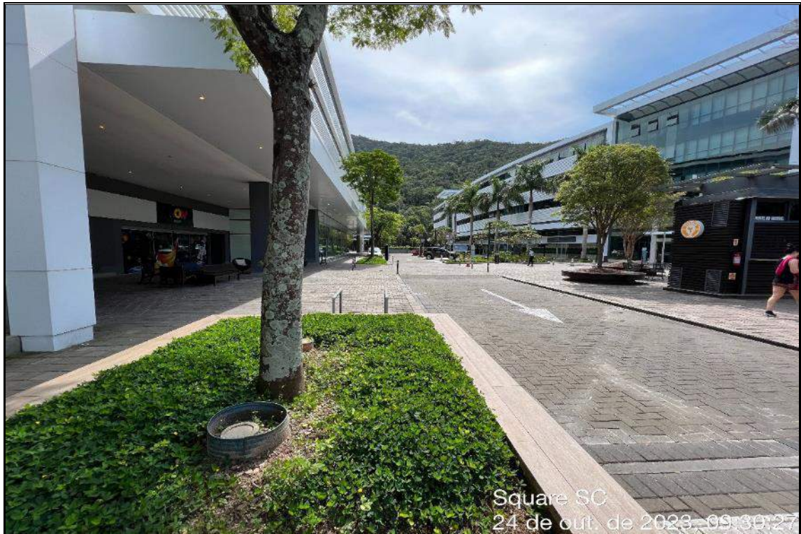
VISTA DA “TORRE CURVA” DIREÇÃO FUNDOS
