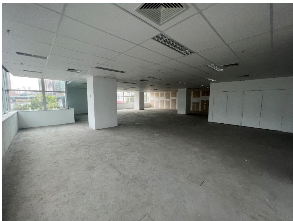
Vista geral do pavimento tipo
