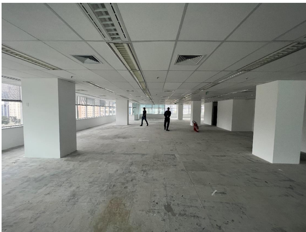
Vista geral do pavimento tipo
