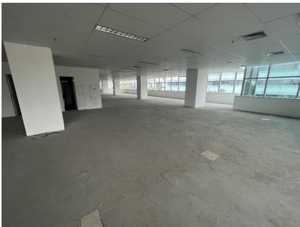
Vista geral do pavimento tipo
